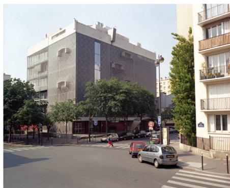
JUCHÉ SUR UNE BOÎTE AUX LETTRES DE LA POSTE POUR PRENDRE DE LA HAUTEUR... AU MOMENT DE DÉCLANCHER ARRIVE LE POSTIER POUR PRÉLEVER LE COURRIER... CELA NE S'INVENTE PAS ET ÉVITE DE PARLER DES FILETS ANTI-CHÛTE (DES CARREUX DE PAREMENT) QUI ENSERRENT LES FAÇADES : MALADIE ENDEMIQUE DE CERTAINES RÉALISATIONS DE CETTE ÉPOQUE.
