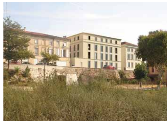
Bâtiment de 12 logements et RPA de 25 logements
