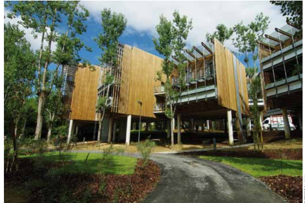
« La canopée », Architecte Arotcharen, Bayonne
