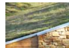
Mélange pour les façades de la pierre récupérée sur le site avec un bardage en mélèze et du végétal sur la toiture
