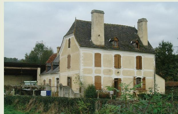
A la fin du XIXe siècle, la brique s'est répandue, notamment à l'est du secteur. Les constructeurs ont su en tirer des effets ornementaux puissants, jouant du contraste coloré entre les éléments de structure en terre cuite (chaînes d'angle, corniches, encadrements...) et les panneaux de murs couverts d'un enduit clair.
