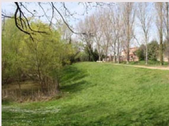
Le bassin de rétention, au cœur de l'opération, est intégré à un parc, lieu de promenade du quartier.
