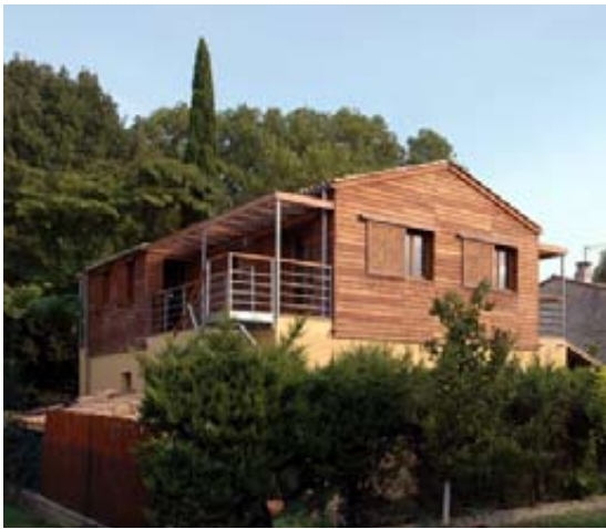
Pavillon reconverti en «maison contemporaine»
