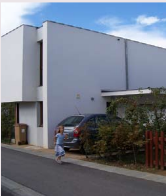
Le positionnement du garage, en recul par rapport à la voirie, permet d'intégrer une place de stationnement privatif contre la maison. ZAC de la Morinais à St-Jacques de la Lande (35)
