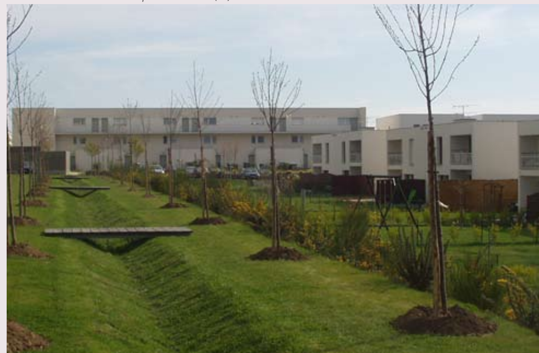
En cœur d'îlot, des jardins structurés par des grandes noues enherbées canalisent les eaux pluviales. ZAC de la Morinais à Saint-Jacques de la Lande (35)
