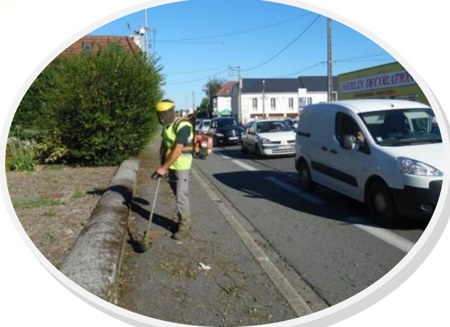
Dés herbage mécanique avec débroussailleuse
