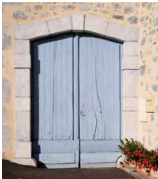
Porte à planches et contre-planches. Bescat.
