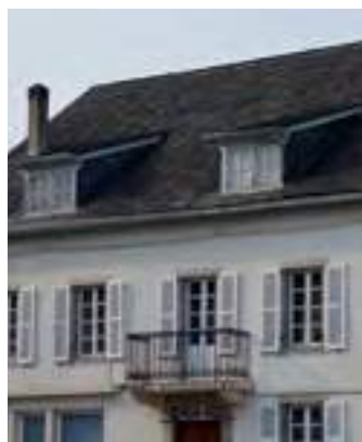
Lucarnes rampantes. Issor.
