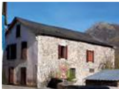
Toiture simple à deux pentes. Bielle.
