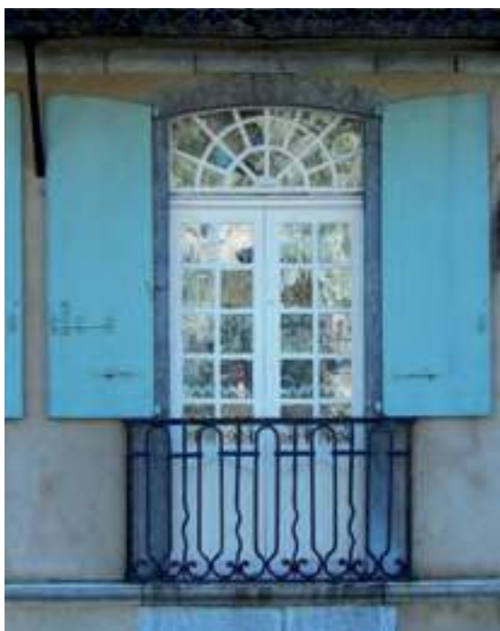
Demi contrevents pleins sur une porte fenêtre et partition à petit carreaux de l'imposte rayonnante et de la fenêtre. Les contrevents épousent la forme incurvée de de la partie supérieure de l'encadrement. XVII e - XIX e siècle.
