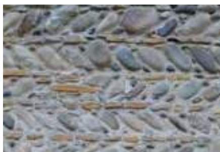
Appareil de galets en fougère sur assises de tuiles. Précilhon.
