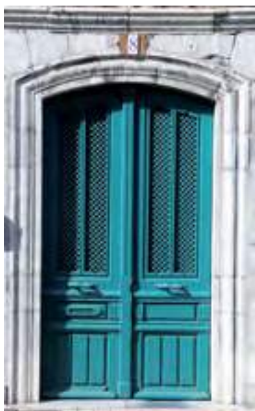
Porte avec sa ferronnerie. Oloron Sainte-Marie.
