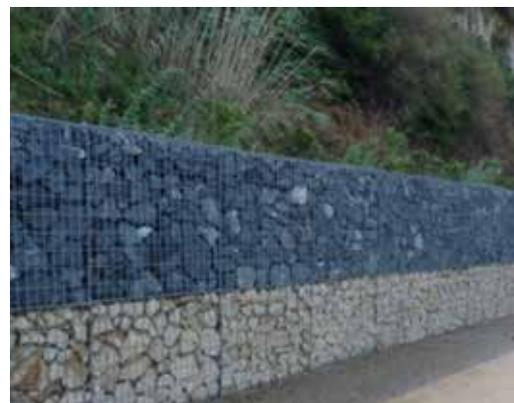
Fig. 8 - Les murs en gabions longent les circulations ©CAUE 64
