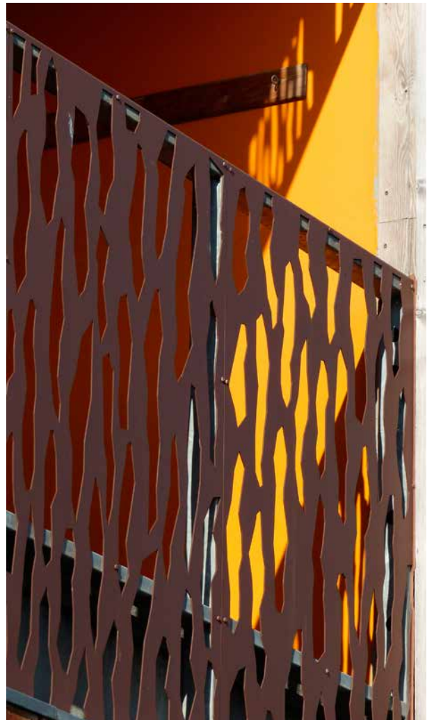
▲ Détail des garde-corps
