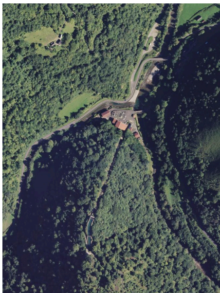
▲ Alimentée par le barrage de Sainte-Engrâce, la centrale siège à la confluence des gaves
