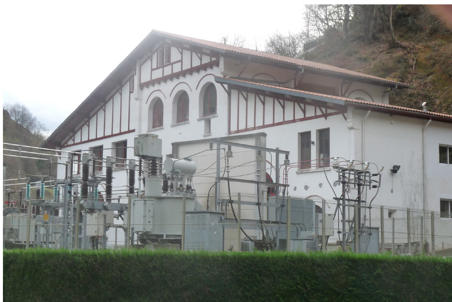
▲ Architecture néo-basque et transformateurs électriques
