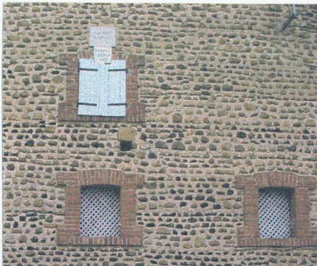
▲ Mur en galets et encadrements en briques (construction 1900)
