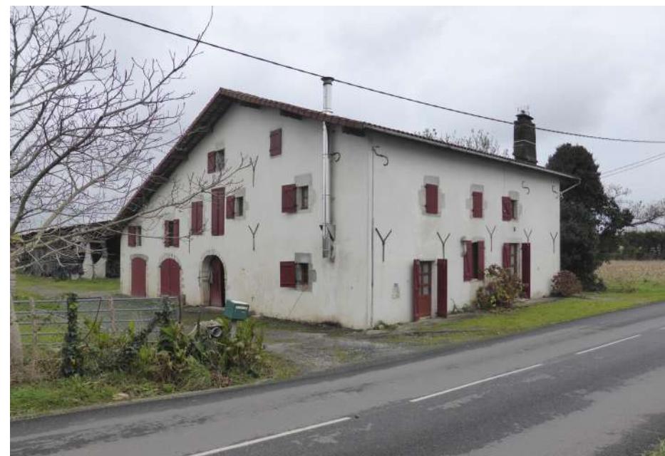
▲ Ferme-bloc alignée en bord de voie le long du fleuve.
