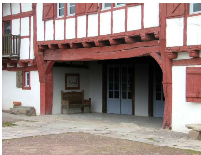
◀ Le savoir-faire du charpentier autorise l'ouverture du lorio*, la maçonnerie sert de remplissage.
