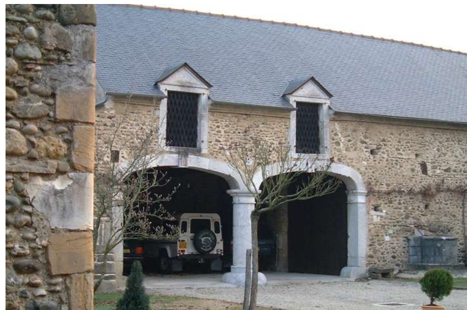
▲ Pierre de taille, corniche moulurée... l'architecture de la grange est particulièrement soignée.
