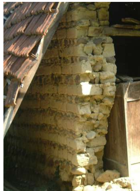
▲ Maçonnerie alternant briques d'adobe et rangées de galets. Maçonneria qui alterna adòbas (teulas de bastir d'adòba) e arruas d'arrebòts.
