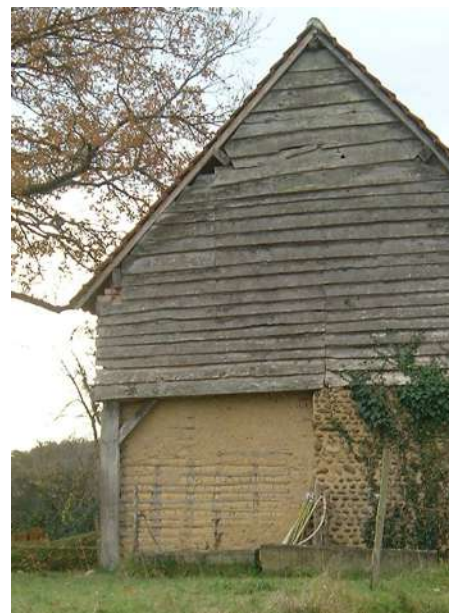
▼ Mur à remplissage en torchis. Muralha a empleada en massacanat.
