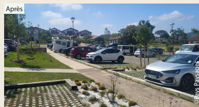
Commune d'Ainhoh - Une gestion directe des eaux de pluie à la parcelle pour une aire de stationnement agréable.
