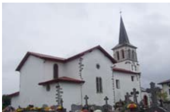
Façades est et nord, vues depuis le cimetière (nov. 2008)
