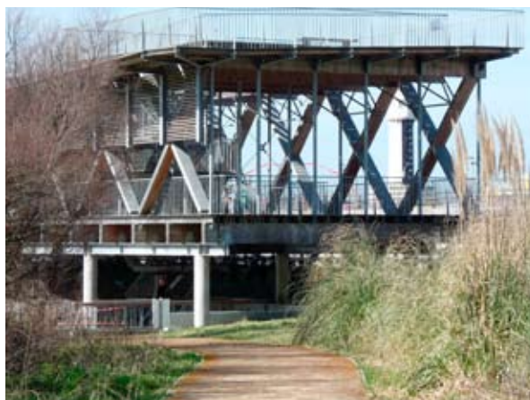
Anglet - Maison de la nature, parc écologique Izadia - P. Madec, architecte - Mutabilis & G. Geoffroy-Dechaume, paysagiste - 2008
