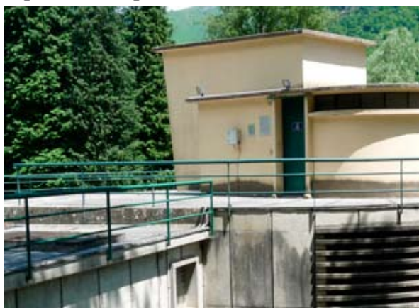
Laruns Geteu - Centrale hydroélectrique
