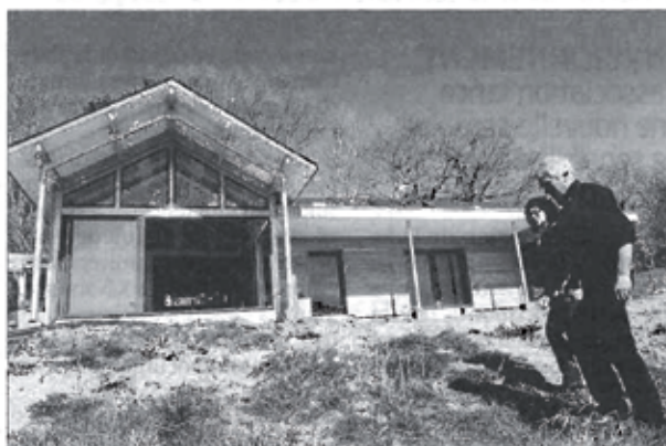
L'écoconstruction est en marche, ici, à Saint-Castin. PHOTO L. LAISSAC
