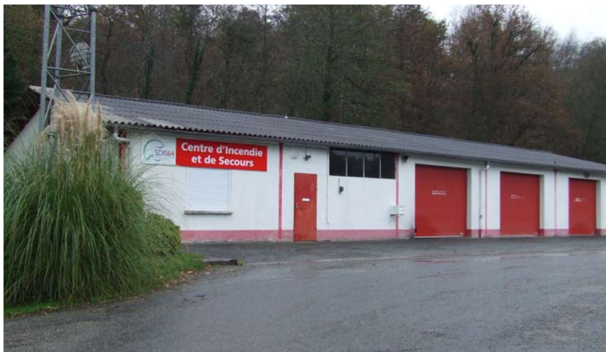
Lasseube - Centre d'incendie et de secours - 2011
