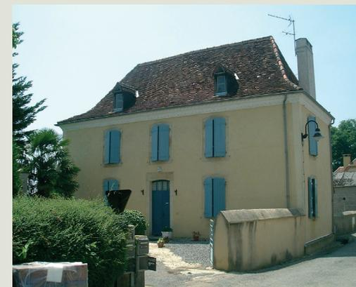
Le toit brisé, dit toit à la Mansart, est assez répandu dans l'ouest du Béarn. La partie inférieure, la plus raide, est couverte de tuiles picon, ou parfois d'ardoises, tandis que la partie supérieure, moins pentue reçoit parfois de la tuile creuse.
