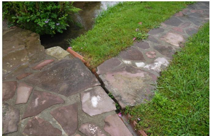
Fig. 16 - Saignées et rigoles canalisant les eaux © CAUE 64
