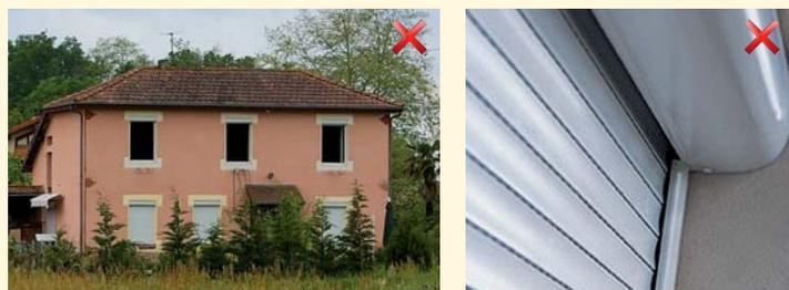
la suppression des volets battants par des volets roulants avec caisson apparent
