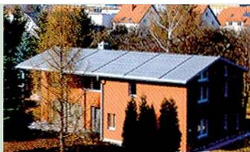
Des panneaux de toiture en zinc à accumulateurs
