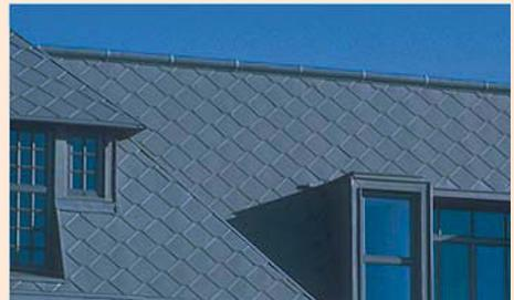
■ les toitures métalliques cuivre, zinc sur tasseaux, zinc à joint debout, bac acier, zinc en petits modules
