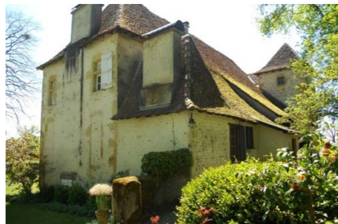
Fig. 7 – La façade arrière du château © le 64
