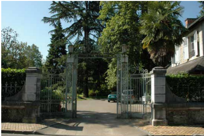
Fig. 5 - L'entrée principale de la villa © CAUE 64
