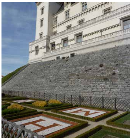
Fig. 5 - Les terrasses au pied du château © CAUE 64
