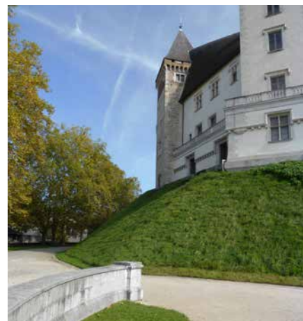
Fig. 7 - La façade Ouest du château © CAUE 64
