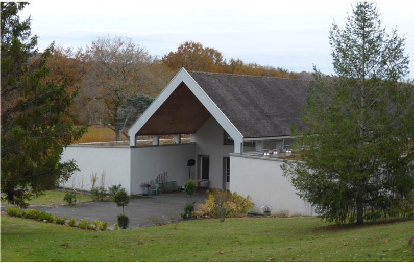
▲ La toiture file en laissant le corps central en retrait, permettant de dégager un préau flanqué de ses deux collatéraux.
