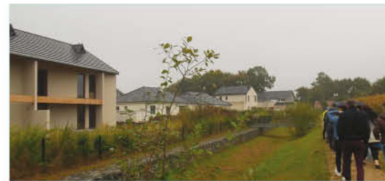
La gestion des eaux pluviales, les noues, le 4 octobre à Sendets © CAUE 64
