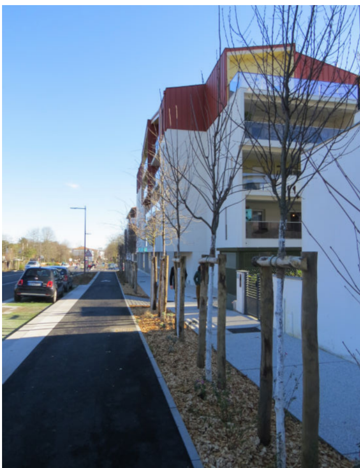
▲ Des arbres alignés en pleine terre et en continu. Les bordures ont été positionnées à fleur pour ne pas entraver l'écoulement de l'eau et hydrater les arbres.
