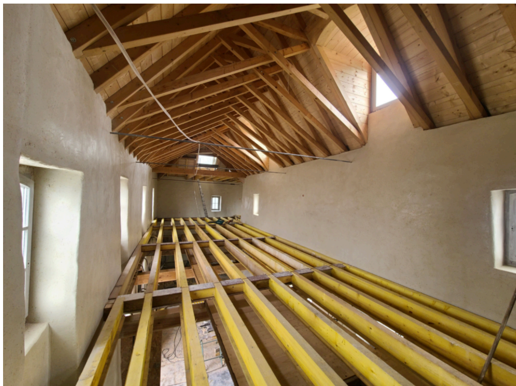
Chantier de réhabilitation de la mairie © Jean-Louis Dumoulein
